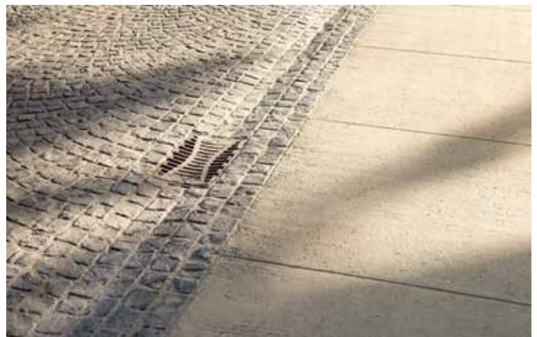
Die Gehbahn aus Ort-beton erhielt als Finish einen Besenstrich.
