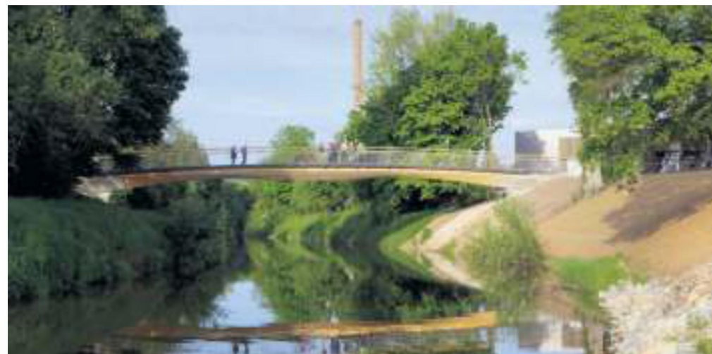
Zukunftweisend: die „Stuttgarter Holzbrücke“ im Remstal
