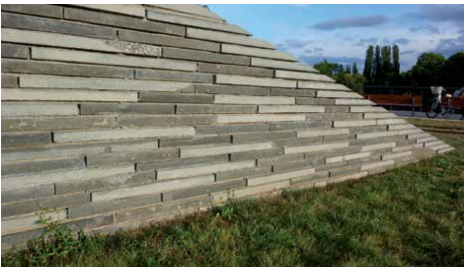
4 Aus Sicherheitsgründen mussten die Mauern vermörtelt und verfugt werden: Das geforderte Refugium für Mauereidechsen wird nun an anderer Stelle verwirklicht.
