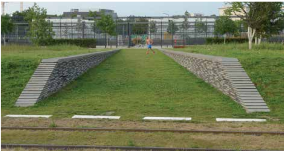
3 Die Höhendifferenz von 90 cm, die bei den ebenen Korridordurchschnitten entsteht, wird durch Stützmauern aus Basaltplatten abgefangen.
