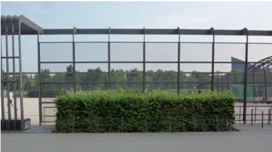
2 Die Spielfelder im Sportband sind von Treillagen aus Metall eingefasst und werden durch Hainbuchenhecken voneinander getrennt.
